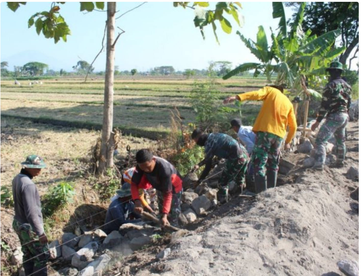
Pembuatan Talud TMMD Reg 121 Kodim Klaten Siap Perkuat Infrastruktur Desa
