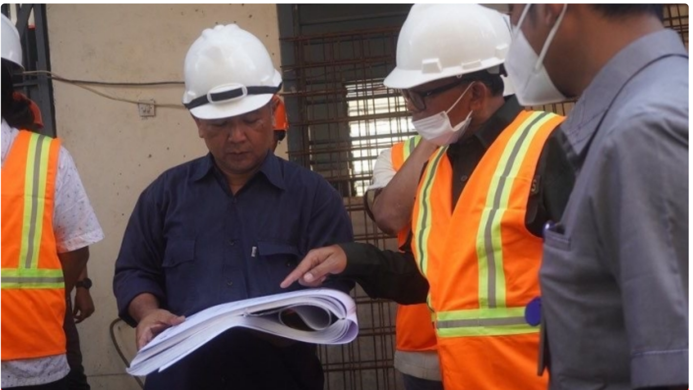
Sesditjen Pemasyarakatan Pantau Progres Pembangunan Rutan Kelas I Semarang
